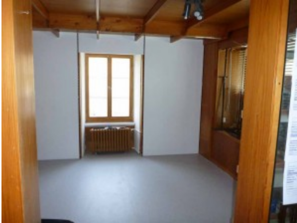
Momentan wird noch kräftig umgebaut
